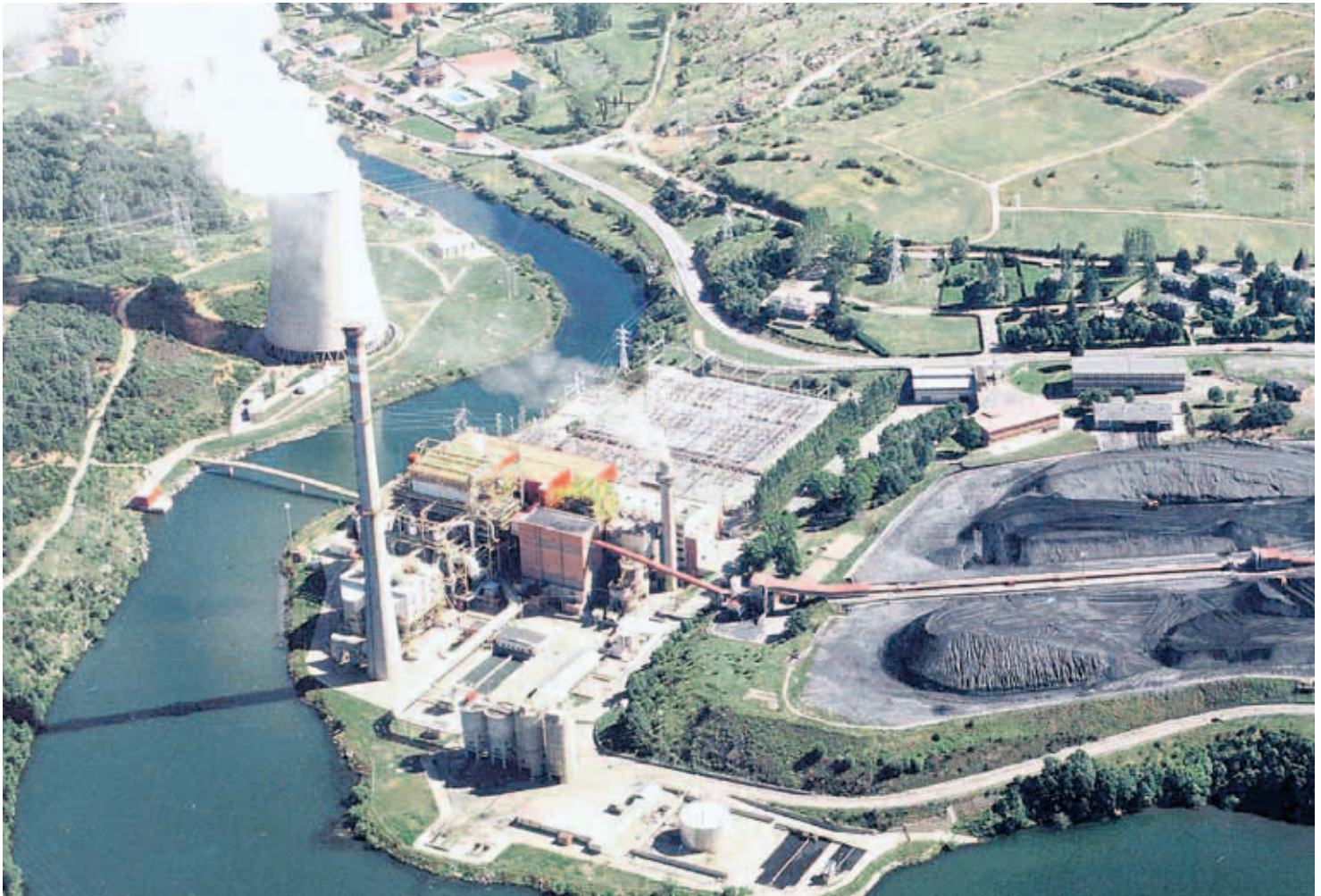
Vista panorámica de la central térmica de Velilla del Río Carrión, en Palencia, propiedad de Iberdrola. :: EL NORTE
