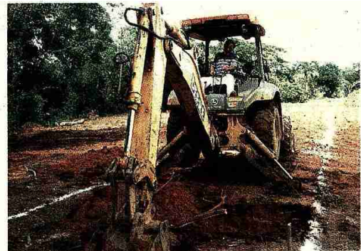
RECUPERACIÓN AMBIENTAL. Sobre estas líneas, canales de agua negra en el barrio de Los Llanos de La Guazara. A la derecha, excavaciones y desbroces para la construcción de filtros verdes
