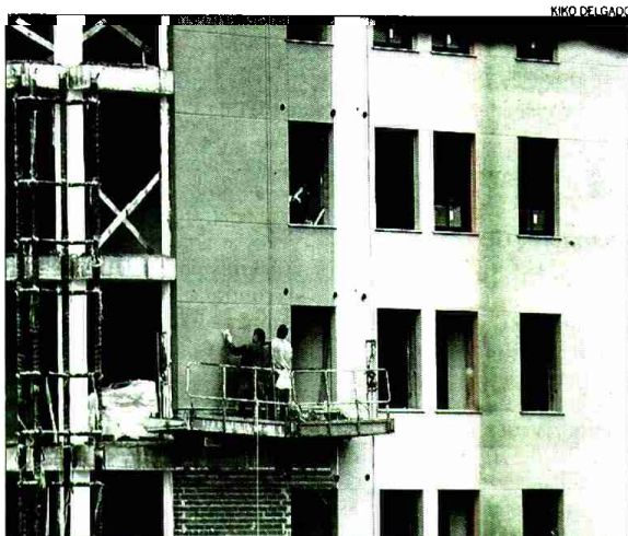
Trabajadores en un edificio de viviendas en construcción en Narón
