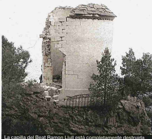
La capilla del Beat Ramon Llull está completamente destruida y resulta peligroso arrimarse a su perímetro desprendido.
