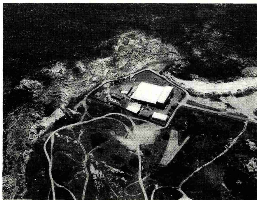
Vista aérea de la planta del Cetga donde se llevará a cabo el proyecto piloto.
