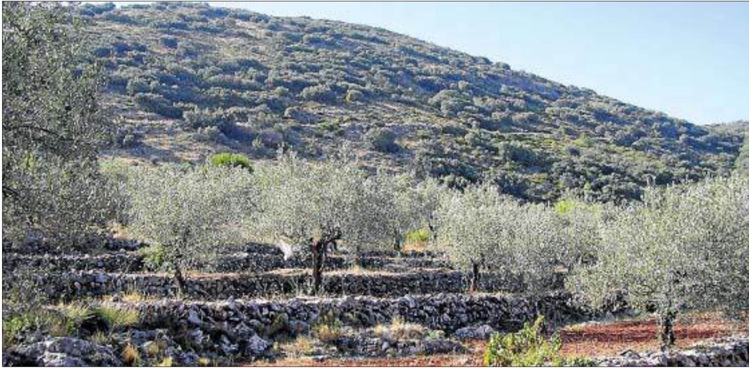
Los muros de piedra sujetan el suelo y permiten los cultivos en áreas marginales donde mantienen la fauna y actúan como cortafuegos LEVANTE-EMV
