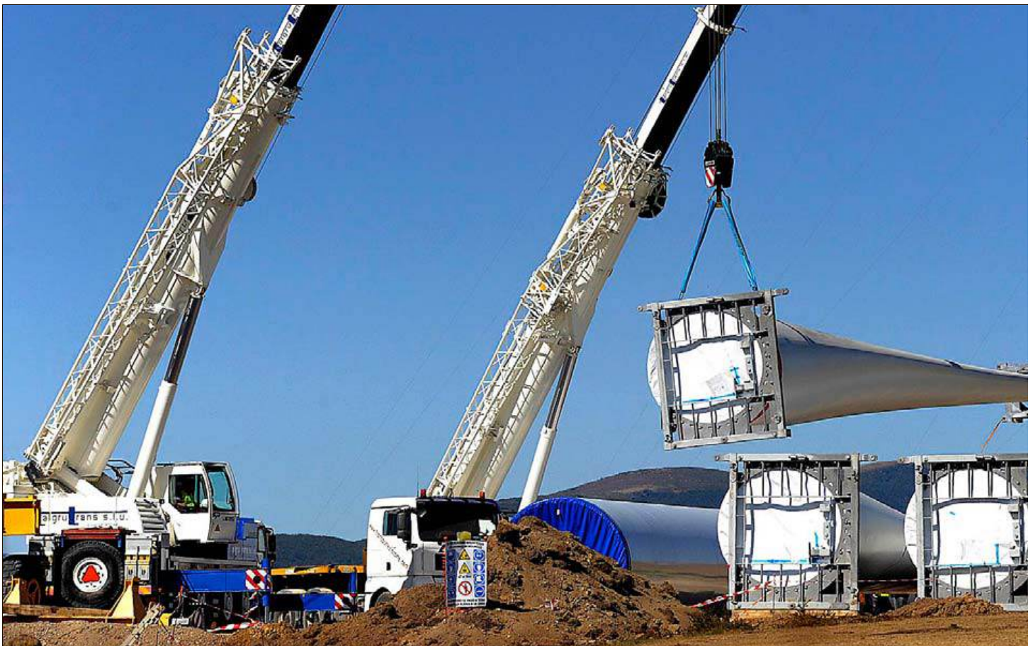
Erección del V112 de Vestas en Cotío; a la derecha, dos torres anemométricas. / MARÍA GIL LASTRA
