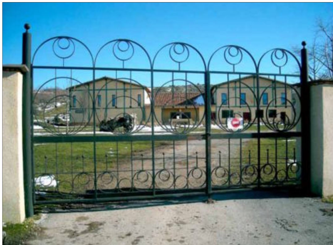
Las instalaciones del centro ambiental de La Lastra permanecen cerradas al público desde el año 2005. / VEGA
