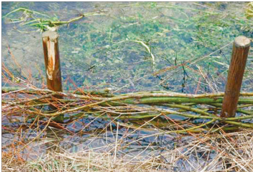
Imagen de archivo de intervenciones ejecutadas en cauces de la zona sur. / DP
