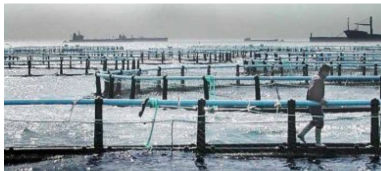
Un operario repasa el estado de unas instalaciones de acuicultura en la costa española. / FUNDACIÓN OESA
