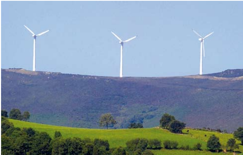
Molinos del parque eólico instalados en el concejo asturiano de Tineo.
