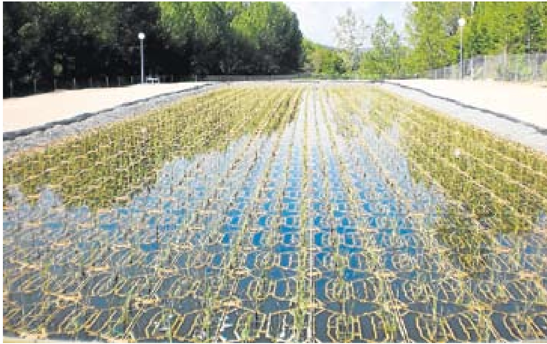
Instalación de plantas macrofitas en una depuradora. HIDROSOLUTION
