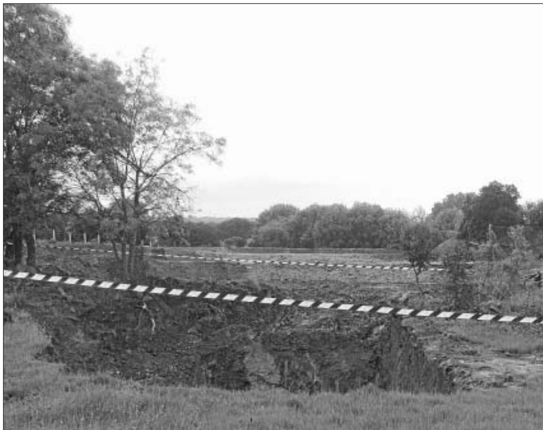
Obras de construcción del humedal artificial.
