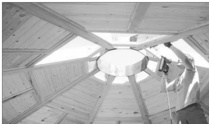
Colocado el tejado.
