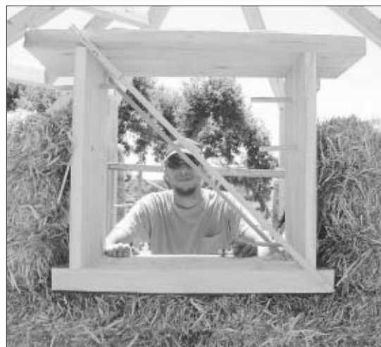
Dejando los huecos para las ventanas.
