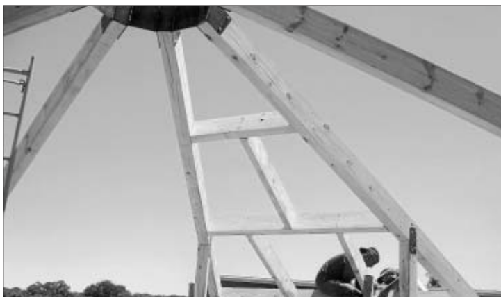
La estructura inicial de la cubierta de la cabaña.
