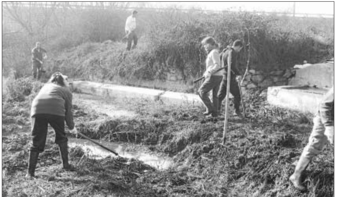
Los voluntarios se afanaron en los trabajos de acondicionamiento de la zona durante toda la jornada de ayer.
