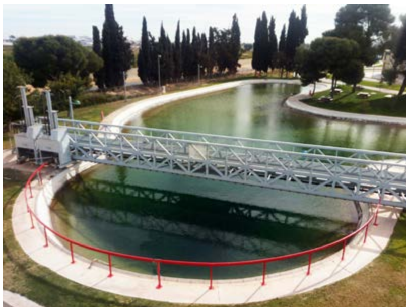
Figura 8. Balsa de calibración externa del CTN. Fuente: CTN.
